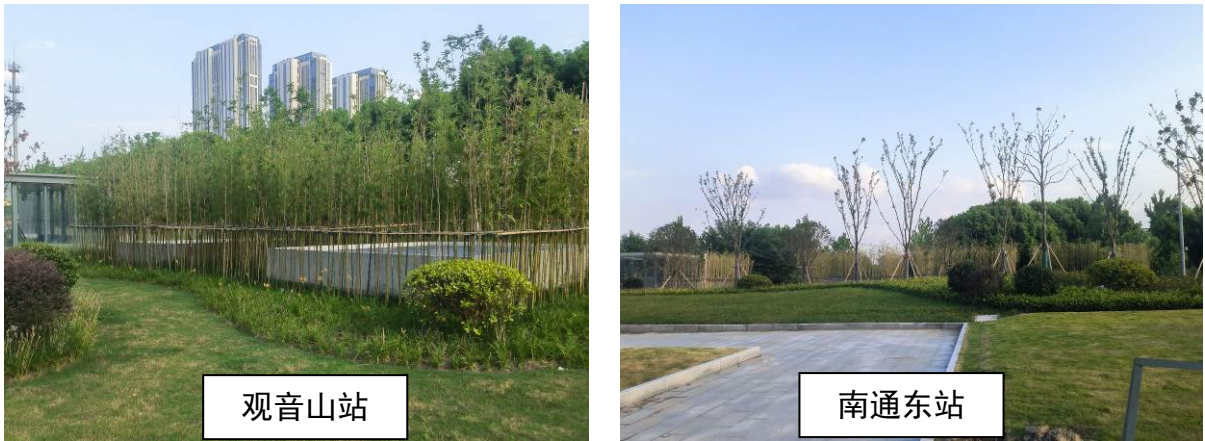
图 6.2-2 部分地下车站风亭照片
