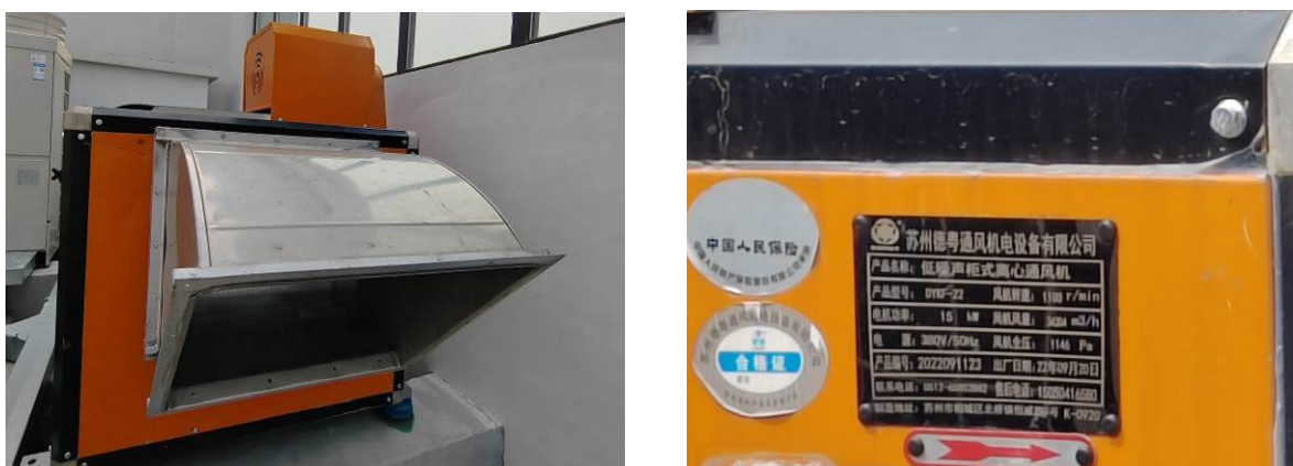
图10.1-2 幸福车辆段油烟净化装置照片
