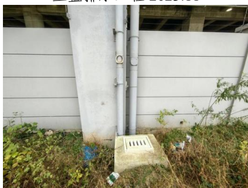
上盖排水工程 2024.12
