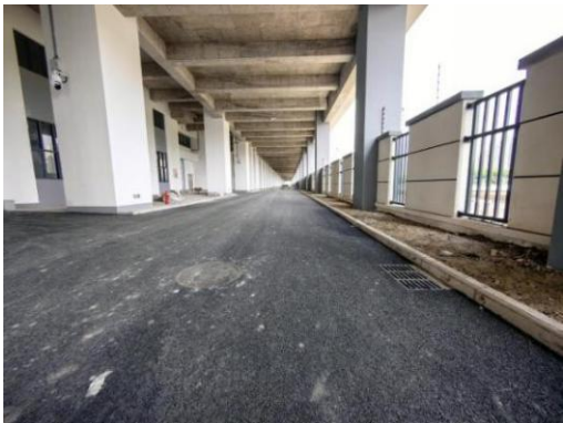
上盖排水工程 2023.6
