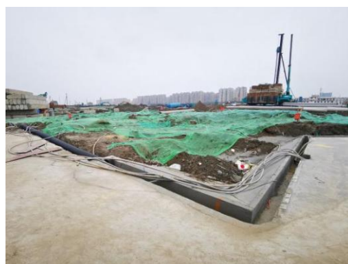
临时苫盖及临时排水沟 2022.1
