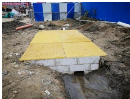
(4) 4#监测点—沉沙池法
