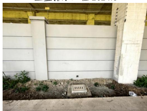
上盖排水工程 2025.3
