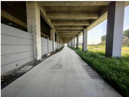
上盖排水工程 2023.7
