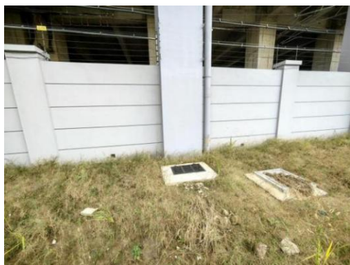
上盖排水工程 2023.11
