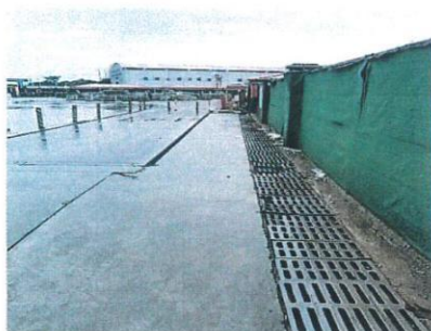
排水沟局部损坏维修前
