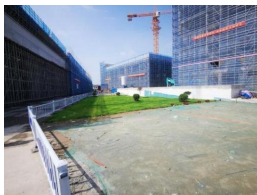
场地临时苫盖及绿化 2022.7
