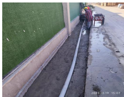
排水沟清理(整改后)2022.10
