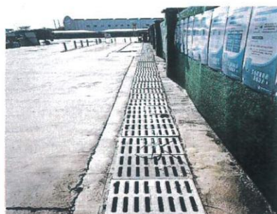
排水沟局部损坏维修后
