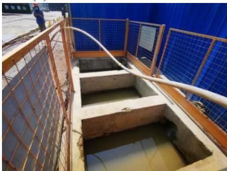
(3) 3#监测点—沉沙池法
