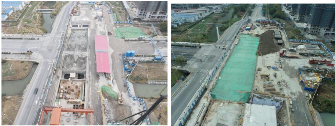
图8-2 施工扰动影像图（2）
