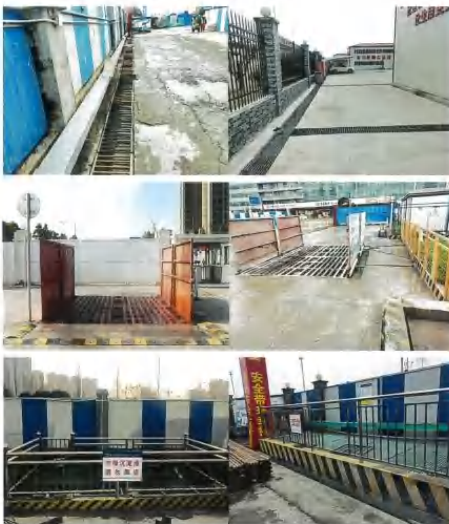
图 2 排水沟、洗车槽及沉沙池使用维护情况
