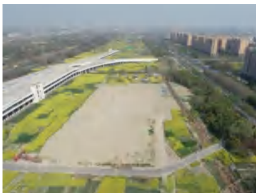
幸福车辆段项目部拆除整治 2025.1
