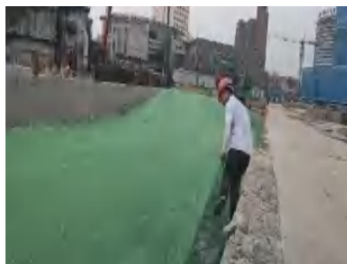
裸土已苫盖(整改后)2022.8
