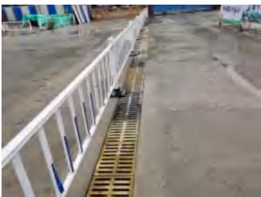
体育公园站临时排水沟 2019.12
