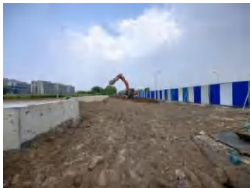
太平路北站表土回填 2023.4
