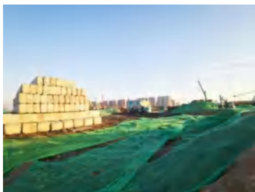
幸福车辆段裸土覆盖 2021.12
