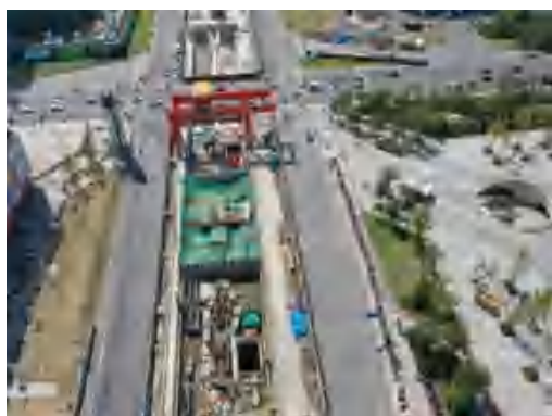
永怡路站渣土坑覆盖 2020.9
