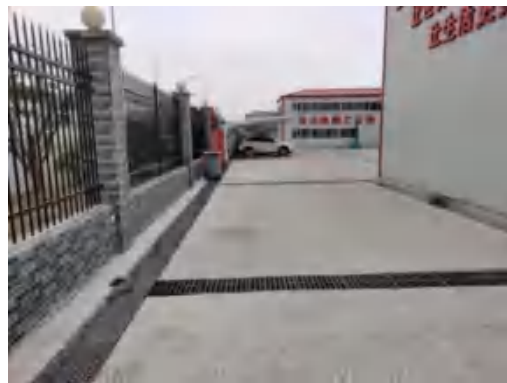
10 标项目部临时排水沟 2019.12
