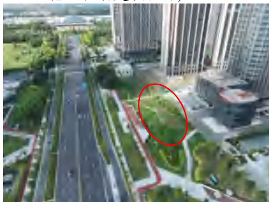
原 3 标永达路站现场工区(绿化)2024.9
