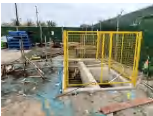
太平路北站 2 号口施工沉淀池 2025.9
