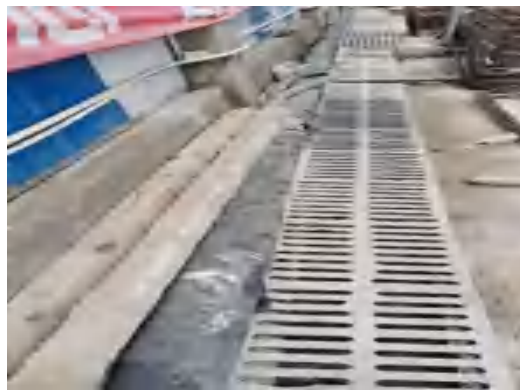
排水沟修复和清理(整改后)2020.5
