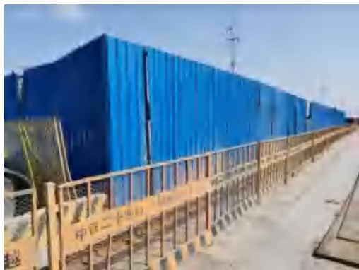
先锋镇站渣土坑 2021.2
