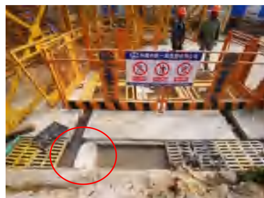
排水沟设置挡水(整改后)2021.3
