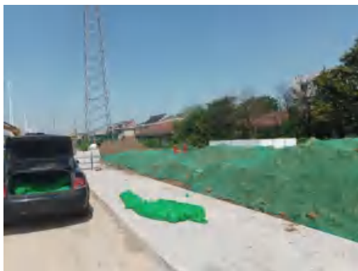
裸土已苫盖(现场整改后)2023.6
