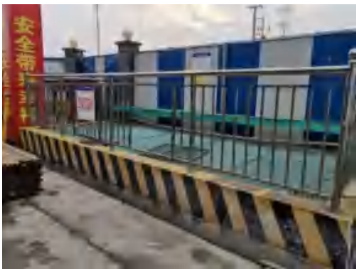
幸福镇站三级沉淀池 2019.12
