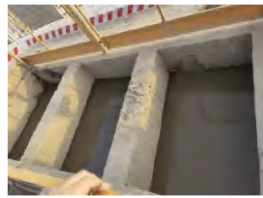
沉淀池清理(整改后)2022.2
