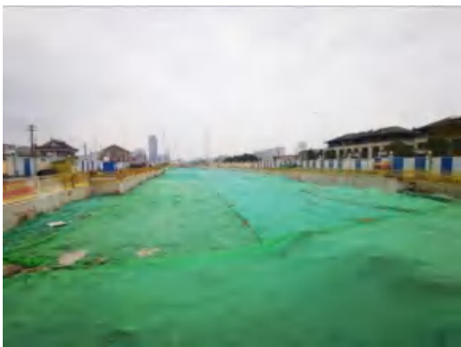
先锋镇站裸土苫盖 2020.12
