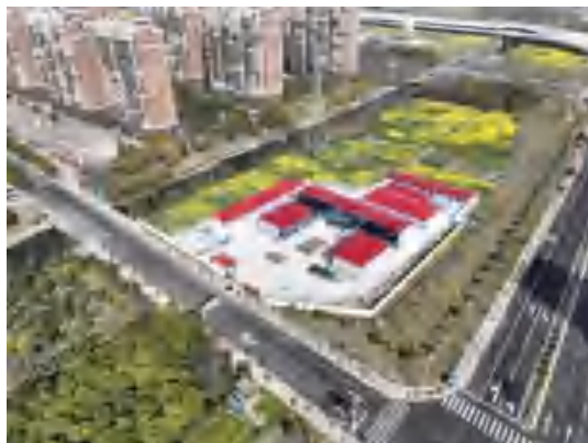
原 2 标项目部驻地(拆除、移交,照片为其 他工程新建项目部)2024.3
