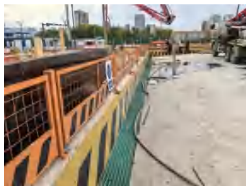
太平路北站 2 号口基坑排水沟 2025.9
