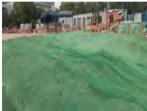
裸土已苫盖(整改后)2022.8
