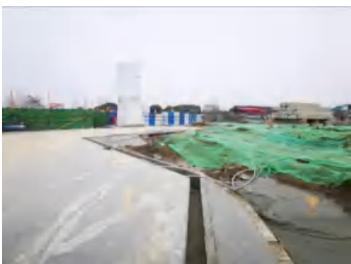
幸福车辆段临时排水沟 2022.1
