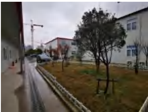
8 标项目部临时排水沟及绿化 2020.1
