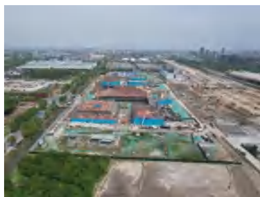
(50)南通火车站出入口、风亭绿化 2025.4
