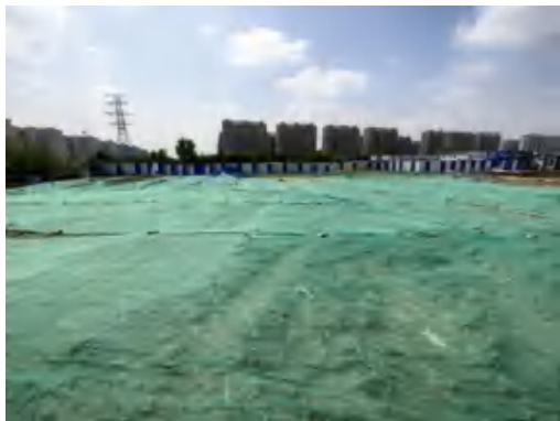
(13)幸福车辆段施工场地整治 2023.4
