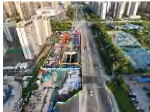
(118)园林路站附属施工 2022.9
