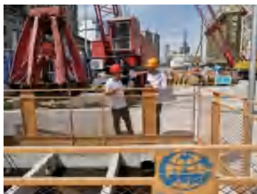
(204)水土保持巡查易家桥站 2020.8
