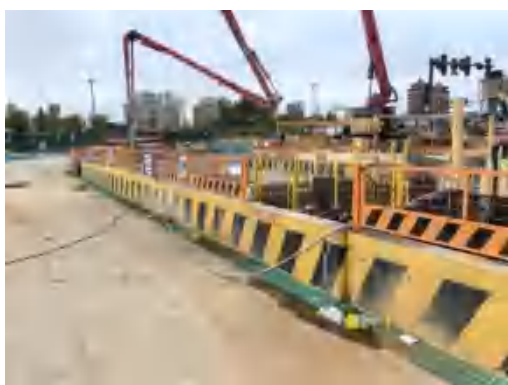
(163)太平路北站 2 号口施工排水沟 2025.9
