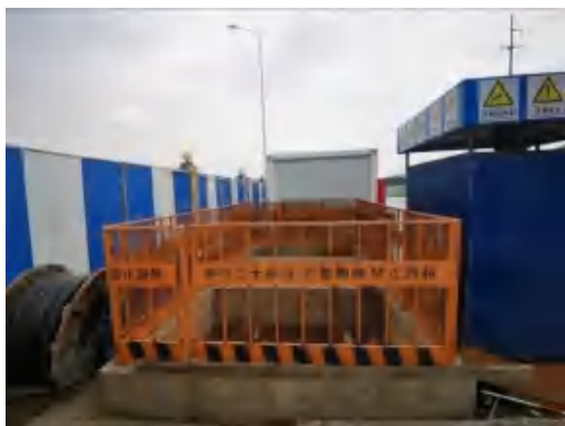
(177)先锋镇站三级沉淀池 2020.12
