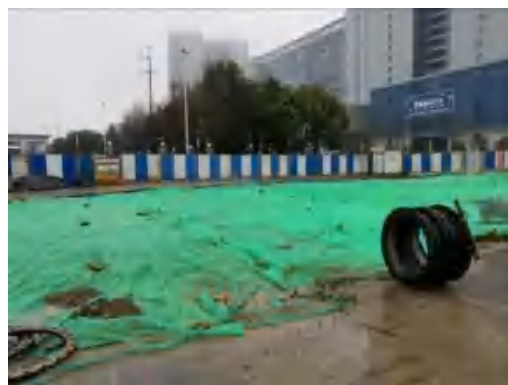
(128)汽车东站裸露面苫盖 2021.2
