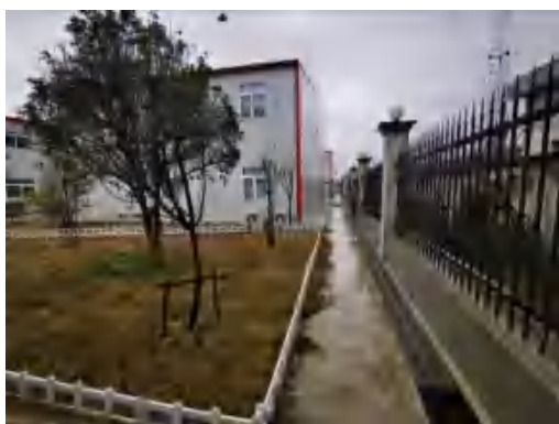
(195)8 标项目部排水沟及绿化 2020.1
