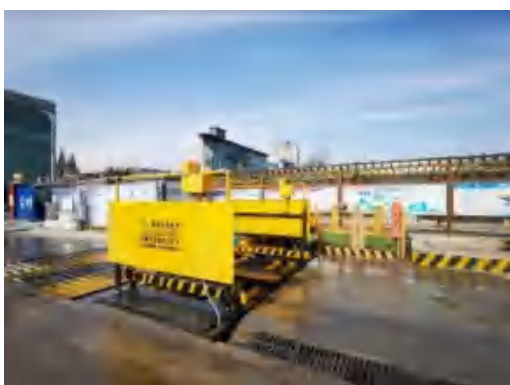
(89)体育公园站洗车平台及沉淀池 2020.12
