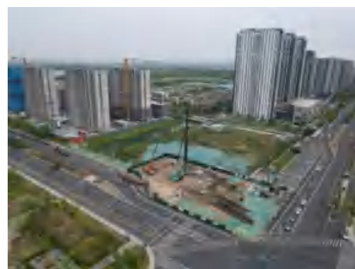
(162)太平路北站 2 号口施工防护 2025.4
