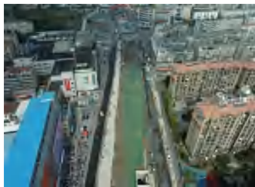
(80)钟秀路站道路恢复苫盖 2021.10
