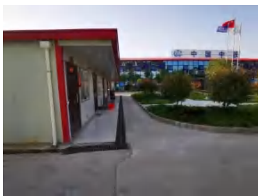
(193)5 标项目部排水沟及绿化 2020.5
