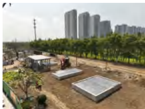
(156)太平路北站绿化施工 2023.5
