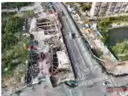
(37)幸福镇站附属施工 2022.9
