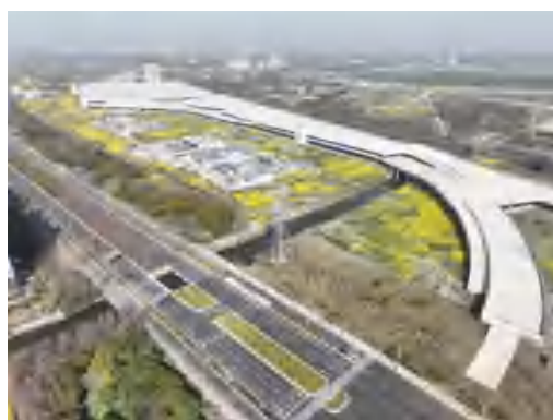
(20)幸福车辆段航拍全貌 2024.3
