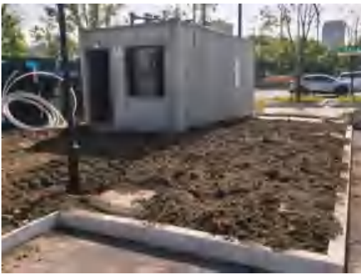
(165)太平路北站 2 号口绿化区覆土 2026.5
