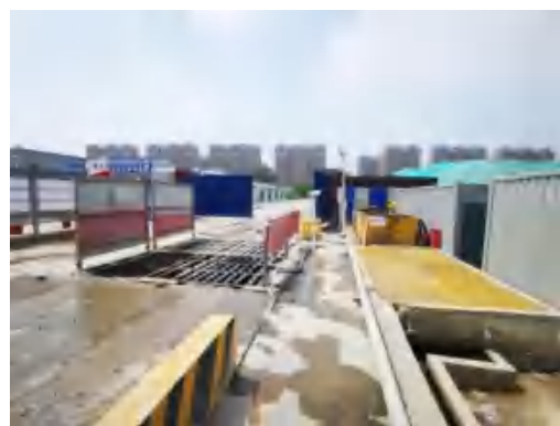
(6)幸福车辆段沉沙池及洗车槽 2022.7
