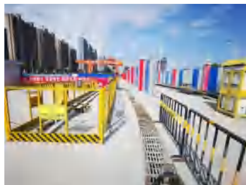
(140)通富路站场内排水沟 2020.9
