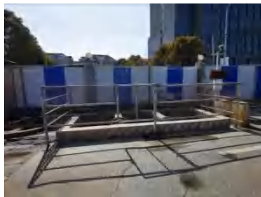
(178)先锋镇站三级沉淀池 2021.2
