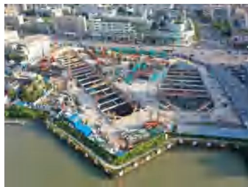
(88)体育公园站施工 2020.9
