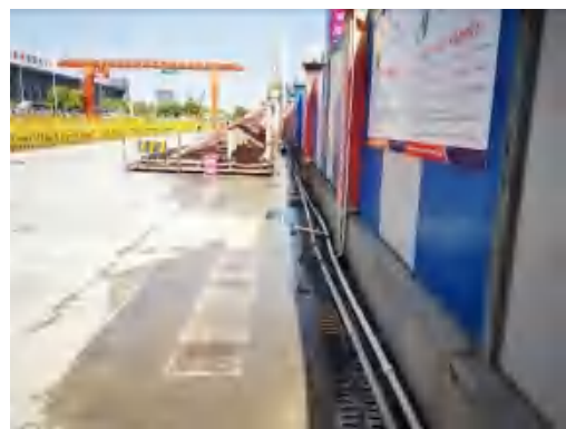
(126)汽车东站临时排水沟 2020.5
