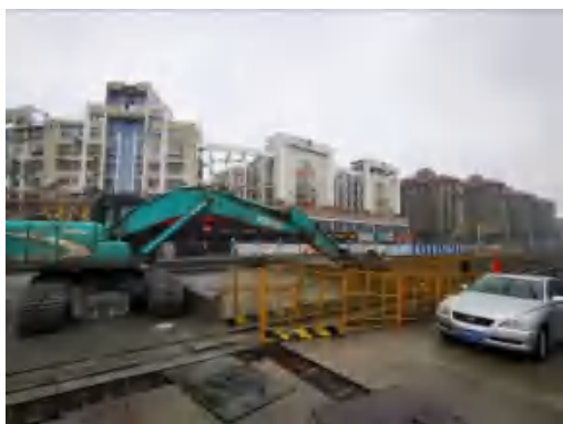
(77)钟秀路站排水沟及渣土坑 2020.11
