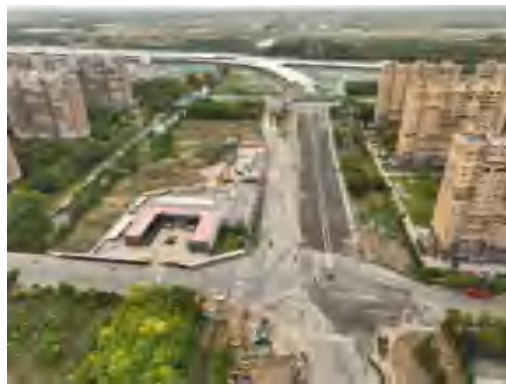
(30)幸福车辆段出入段线道路恢复 2023.3
