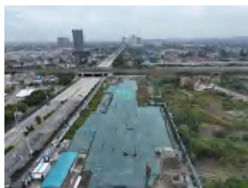
(170)南通东站场地覆盖防护 2022.10
