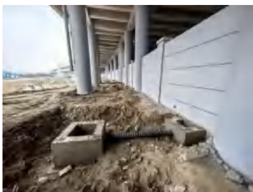
(11)幸福车辆段排水工程建设 2023.3
