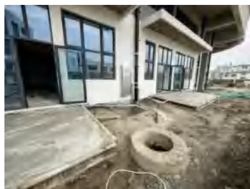
(12)幸福车辆段排水工程建设 2023.3
