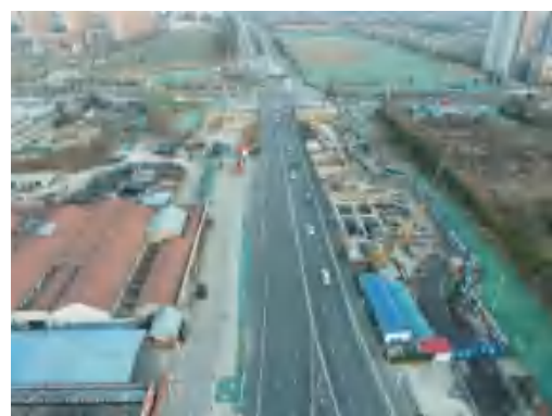
(154)太平路北站施工面貌 2021.12
