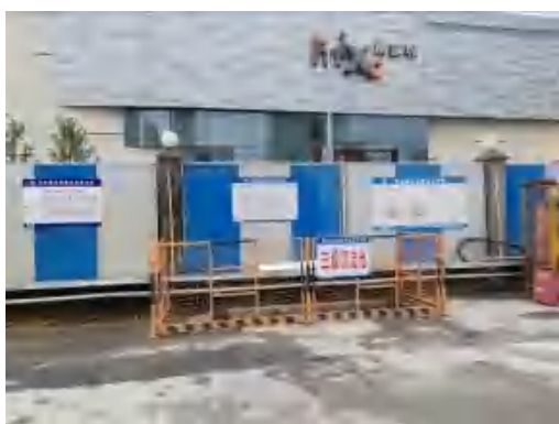
(59)永怡路站三级沉淀池 2020.12
