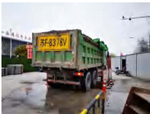
(125)汽车东站运渣车辆出站冲洗 2020.3
