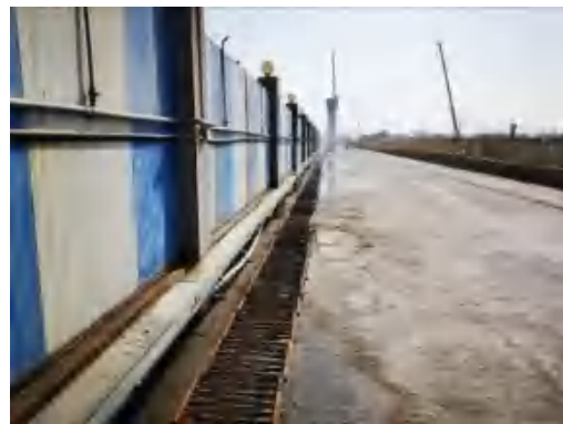
(152)太平路北站临时排水沟 2021.3
