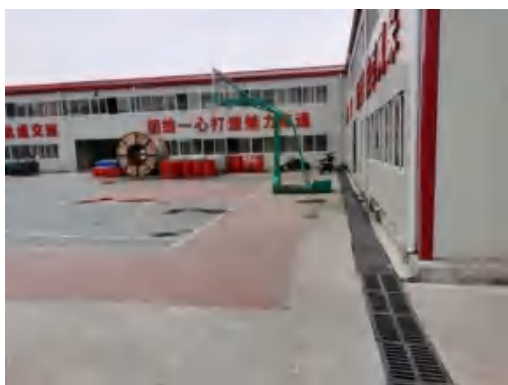
(197)10 标项目部排水沟 2019.12
