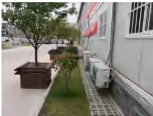
(191)3 标项目部排水沟及绿化 2020.5
