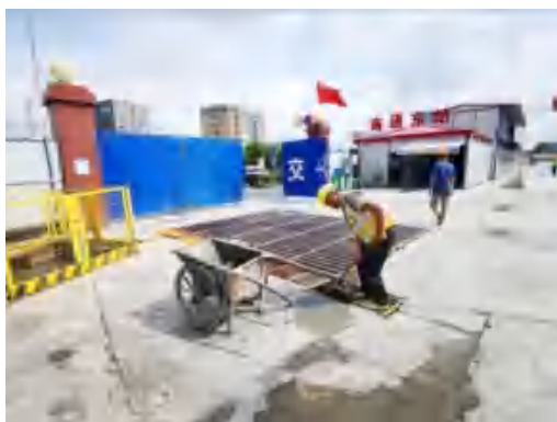
(167)南通东站洗车槽清理 2020.9
