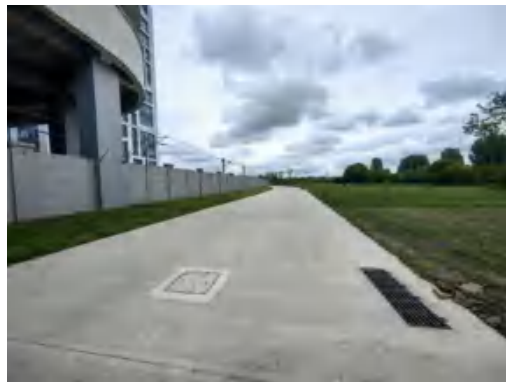
(22)幸福车辆段排水工程 2024.6
