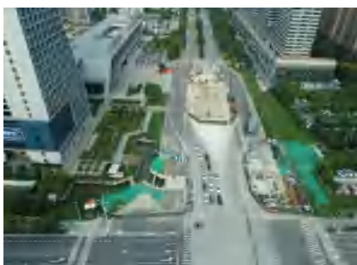
(129)汽车东站裸露面苫盖（航拍）2021.6
