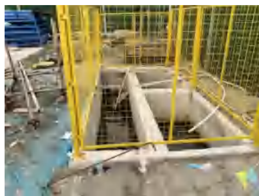
(164)太平路北站 2 号口施工沉淀池 2025.9
