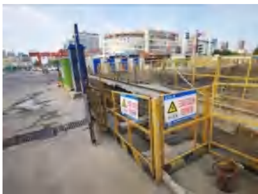
(79)钟秀路站三级沉淀池 2021.9
