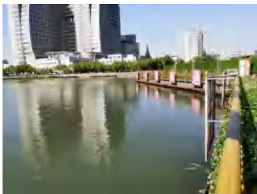
(87)体育公园站濠河侧钢板桩围堰防护 2020.5
