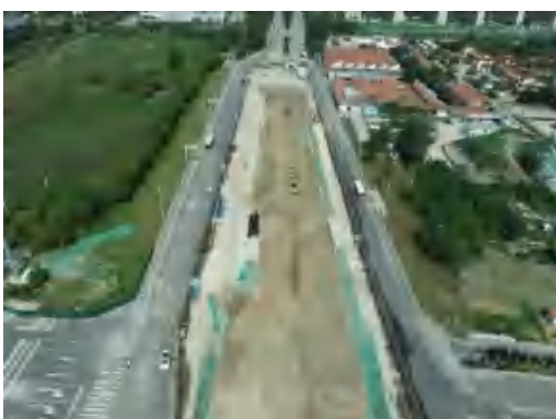
(153)太平路北站道路恢复施工 2021.6
