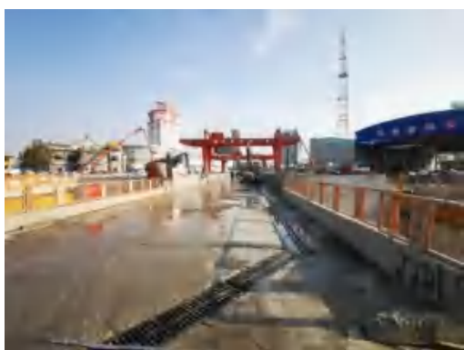
(91)体育公园站临时排水沟 2021.11
