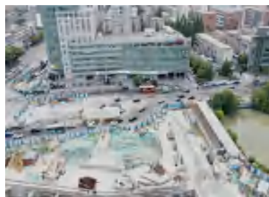
(92)体育公园站施工面貌 2022.6
