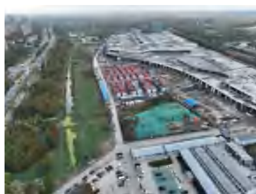
(10)幸福车辆段施工面貌 2022.11
