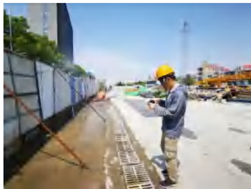
(206)水土保持巡查先锋镇站 2021.6
