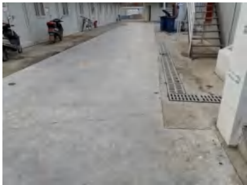
(189)2标项目部排水沟 2019.12
