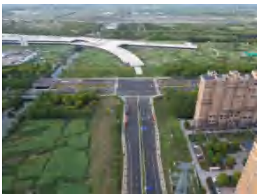
(31)幸福车辆段出入段线植被恢复 2024.4
