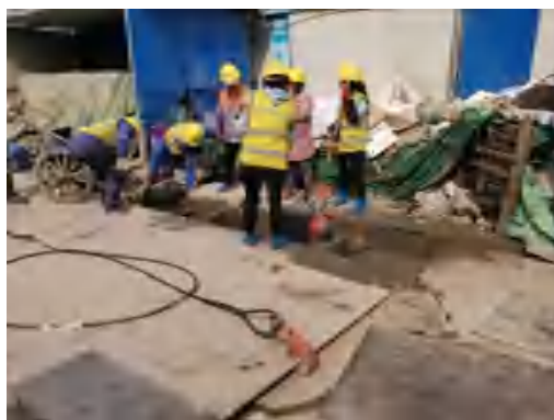
(78)钟秀路站沉淀池清理 2021.3
