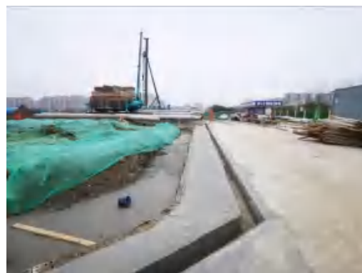
(4)幸福车辆段临时排水沟 2022.1
