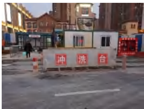
(67)北城大桥站洗车槽 2019.12
