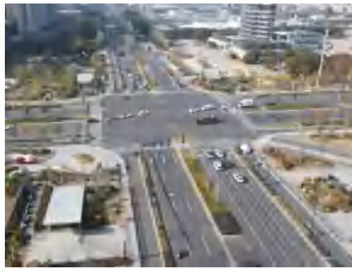
(150)通富路站绿化航拍 2025.12
