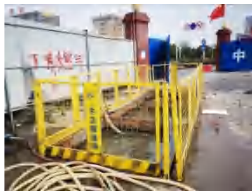
(168)南通东站三级沉淀池 2020.12
