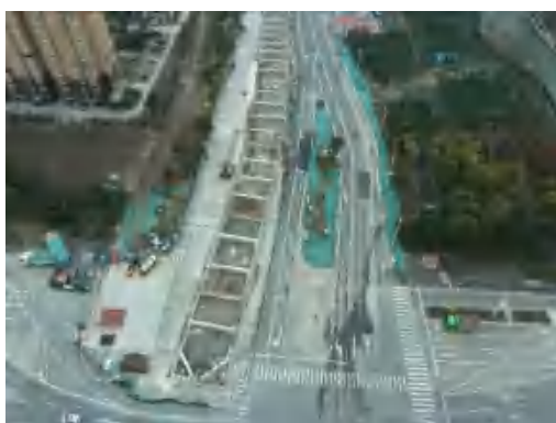
(28)幸福车辆段出入段线施工防护 2022.1
