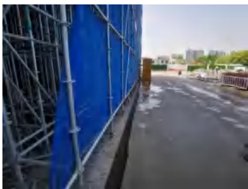
(5)幸福车辆段临时排水沟 2022.7
